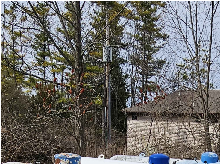
5 EXISTING POWER POLE/TRANSFORMER SCALE: N.T.S.
