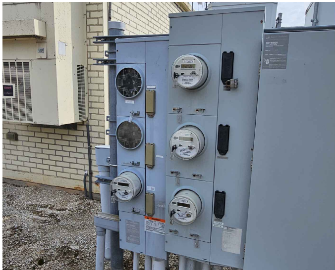
6 EXISTING METER CENTER/ FRAME SCALE: N.T.S.
