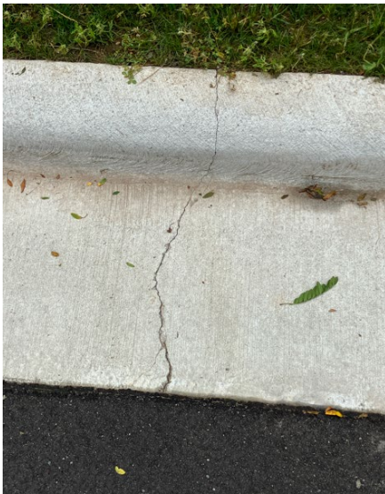
229 N. Mill Street
