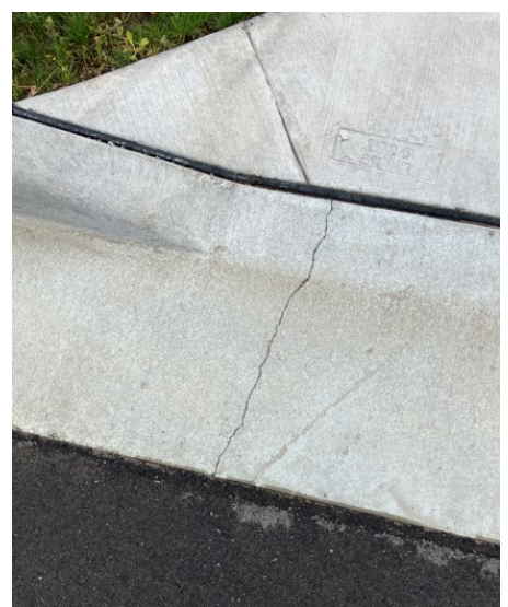
219 N. Mill Street
