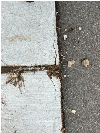
119 N. Mill Street
